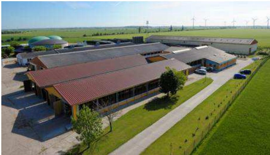
**Milchviehbetrieb Selben:** Kraft-Wärme-Kopplung mit Nahwärmenetz und vor Ort produziertem Biogas
