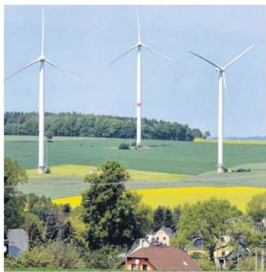
Diese drei Windräder drehen sich schon seit einigen Jahren auf der Flur zwischen Pfaffengrün und Limbach – ein weiteres, rund 65 Meter höheres, soll hinzukommen. FOTO: JACOB THIES
