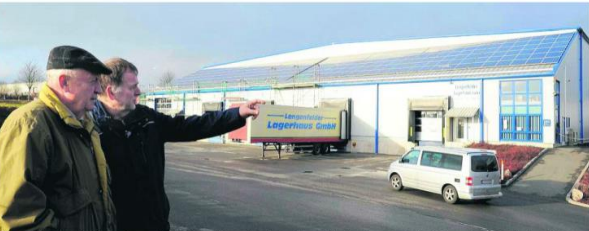
Mit der Kraft der Sonne. Seniorchef Horst Ehrentraut (links) und Systemlieferant Dieter Zisowsky blicken auf eine mit moderner Fotovoltaik-Technik ausgerüstete Lagerhalle. Die mehr als 100.000 Euro teure Installation geht noch in dieser Woche in Betrieb und deckt den gesamten Energiebedarf der Lengenfelder Lagerhaus GmbH. FOTO: FRANK MÄRTLI
